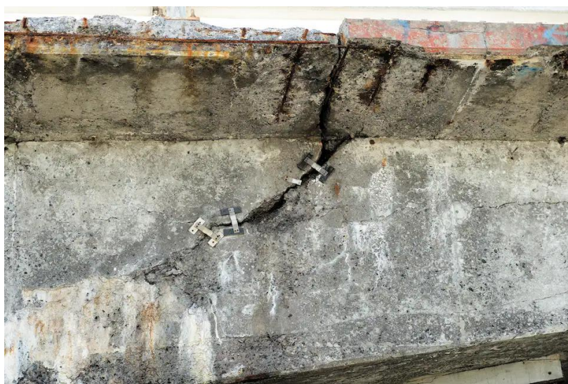
Figure 1-1 Fissures sur le pont de l'autoroute 520 tirée du Journal de Montréal (2020)
