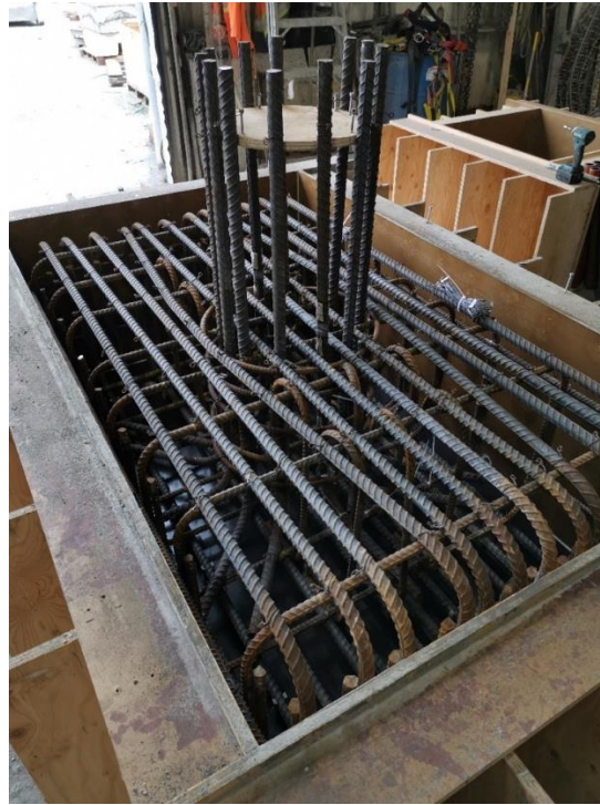
Figure 4-1 Cage d'armatures de la semelle P4
