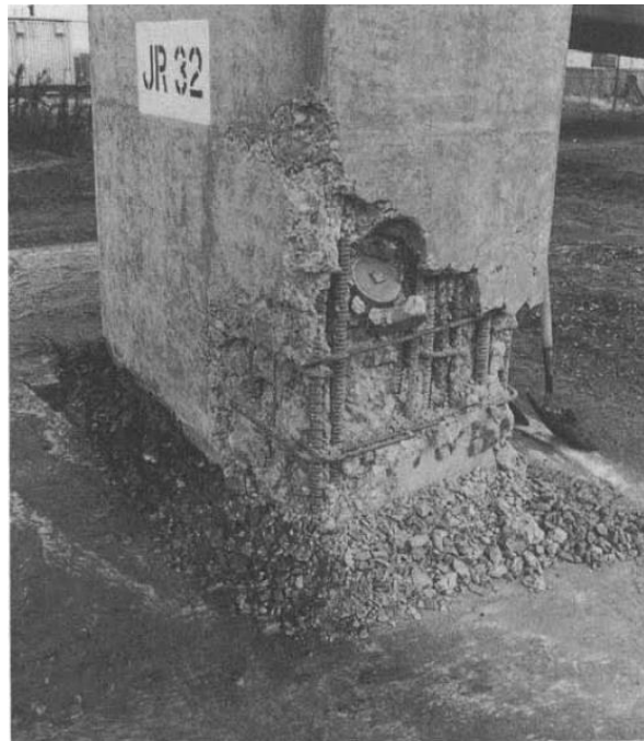
Figure 2-13 Rupture du joint de chevauchement, séisme de Loma Prieta 1989 (Priestley et al., 1996)
