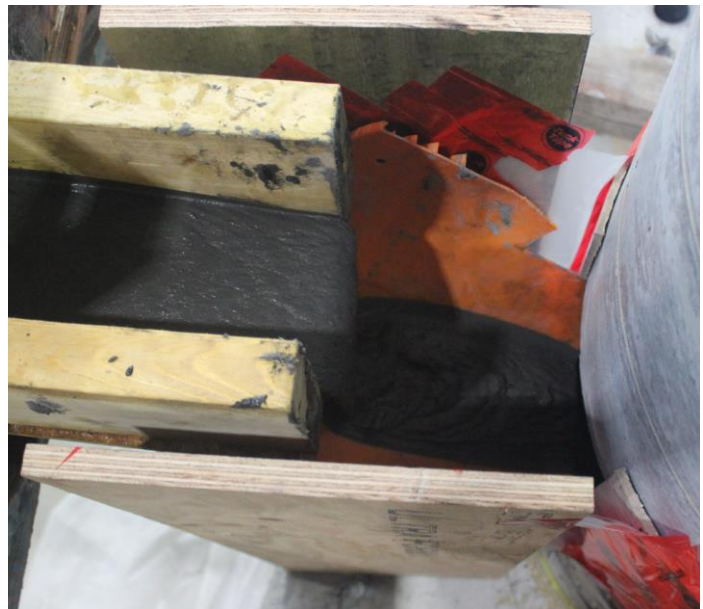
b) Vue du haut du BFUP qui coule dans le joint
