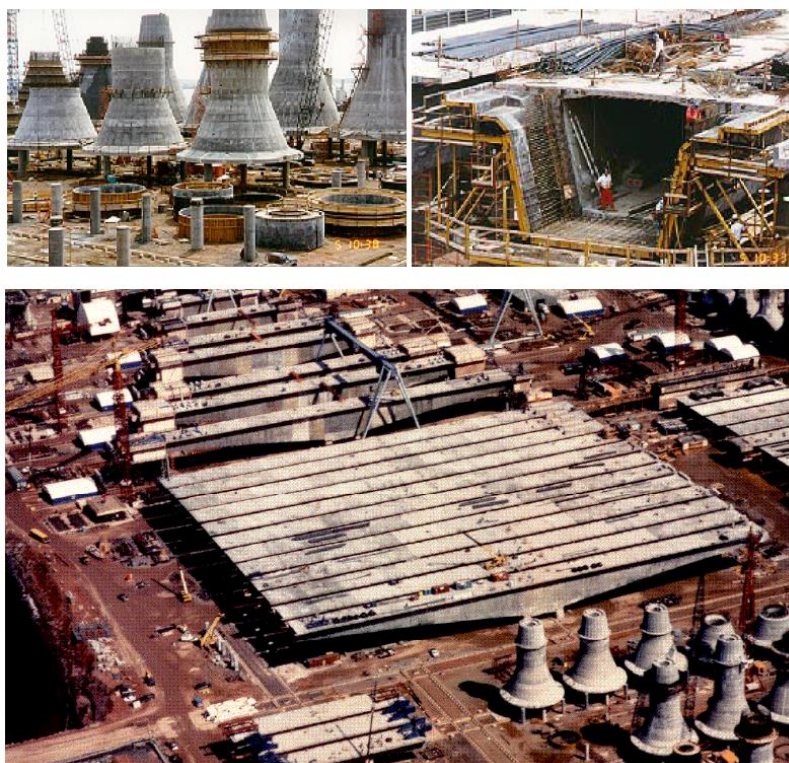
Figure 1-3 Préfabrication du pont de la Confédération (Massicotte, B. et al., 2011)
