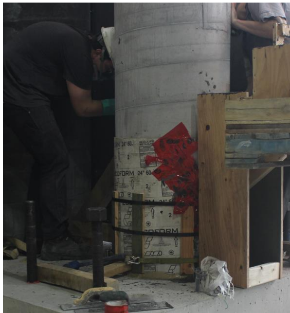
a) Portes utilisées lors de la coulée (une cachée derrière la colonne)
