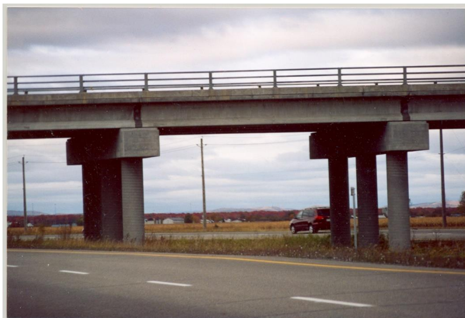
Figure 1-4 Piles de ponts faites de colonnes multiples circulaires (Massicotte)
