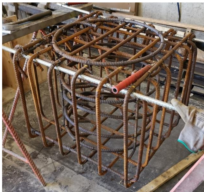
Figure 4-2 Cage d'armature du chevêtre
