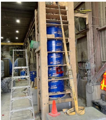
Figure 4-4 Coffrage du fût lors de la coulée des colonnes
