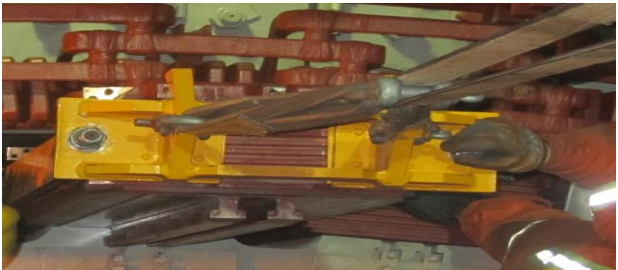
Figure 3.3 Fer du pôle avec deux cônes en forme de «T»
