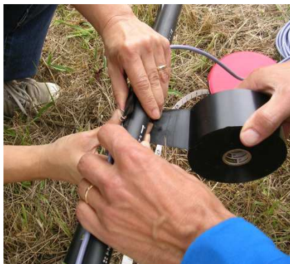
Figure 3.15 : Fixation de la sonde sur le tube
