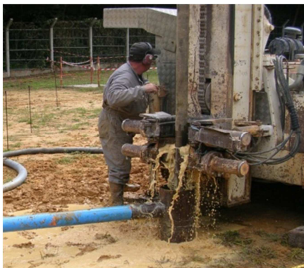
Figure 3.4 : Forage par rotary à boue (bac à boue illustré à droite)
