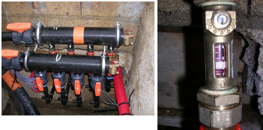
Figure 3.9 : Raccordement des tuyaux aux nourrices et débitmètre
