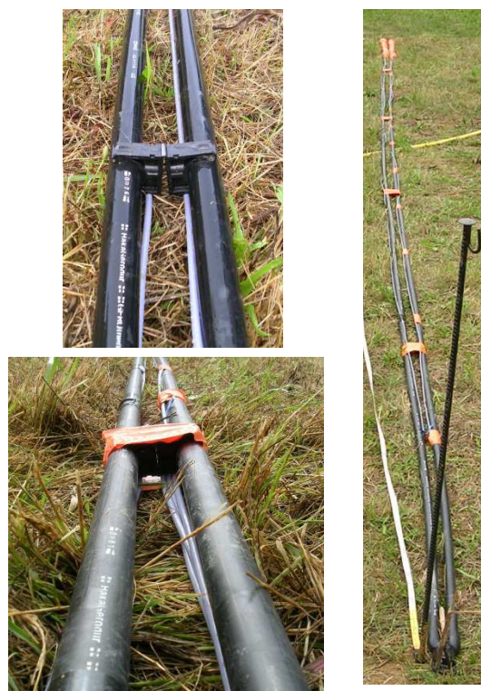
Figure 3.5 : Écarteurs entre les tubes
