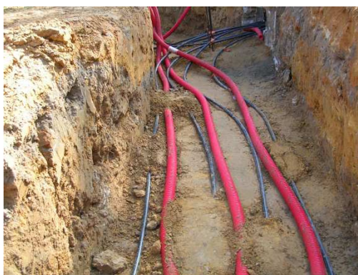
Figure 3.11 : Fourreaux (en rouge) et tubes d'alimentation et de retour (en noir)
