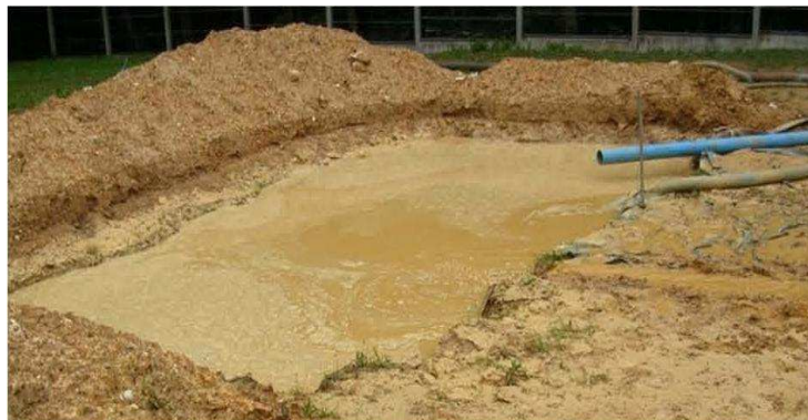
Figure 3.4 : Forage par rotary à boue (bac à boue illustré à droite)
