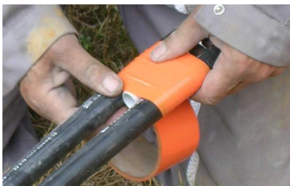
Figure 3.18 : Écarteur improvisé du puits 8
