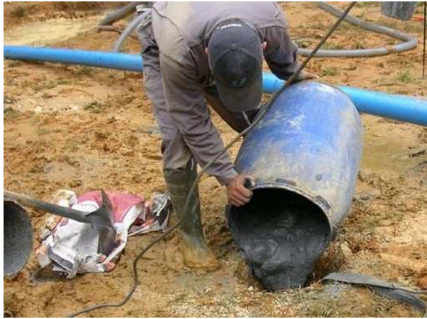
Figure 3.6 : Remplissage manuel d'un puits
