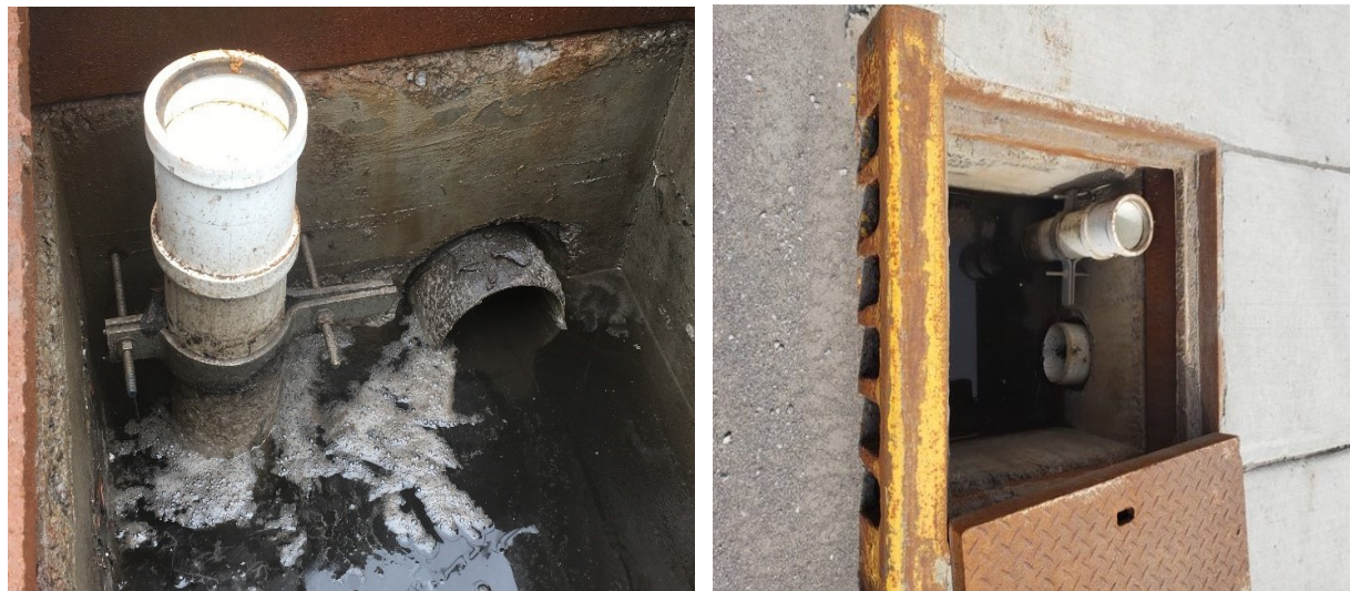
Figure 3.6: Images du puisard d'entrée de la CBR (2019)
