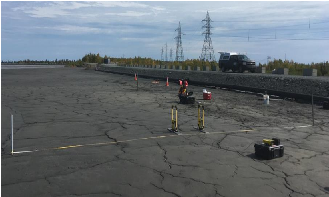
Figure 3.14 Mesures de la Vitesses des ondes électromagnétiques en mode CMP avec le géoradar
