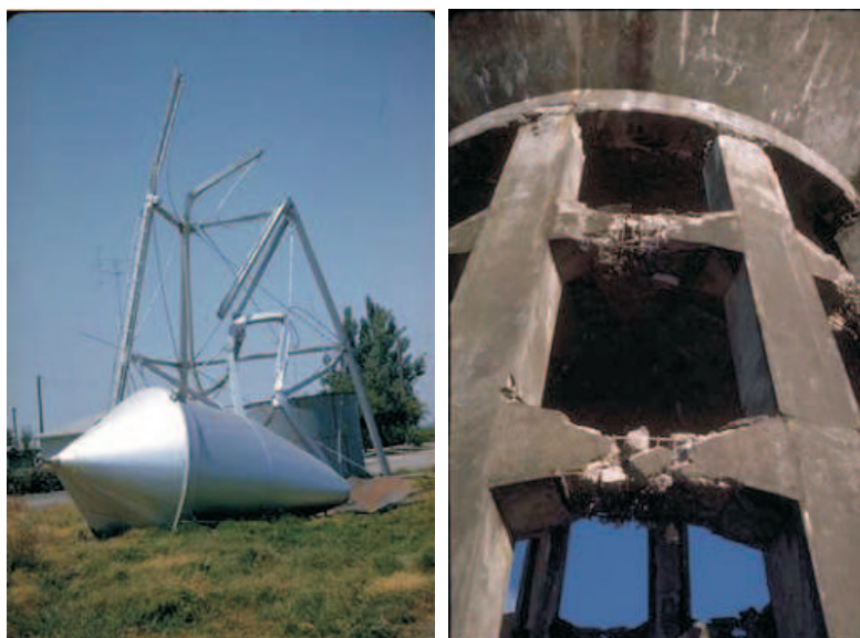
Figure 2.13 (a) Rupture par cisaillement du support et destruction d'un réservoir élevé- (b) Endommagement du support d'un réservoir élevé en béton-(Source : Malhotra (2006))
