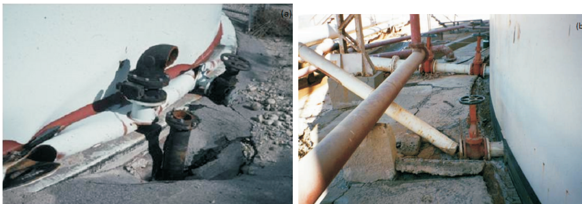
Figure 2.7 (a)Rupture de la conduite d'entrée-sortie due au flambement de la paroi d'un réservoir-(b) Rupture de canalisation d'approvisionnement d'un réservoir due au glissement de sa base (Source : Malhotra (2006))
