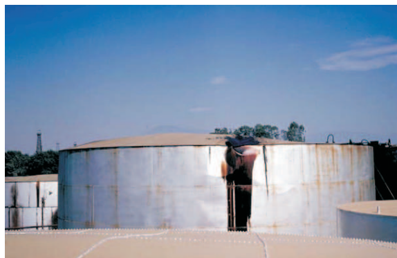
Figure 2.5 Déformation de la partie supérieure de la paroi et du toit d'un réservoir (Source : Malhotra (2006))
