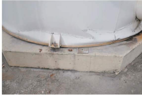
Figure 2.9 Rupture des connections d'ancrage d'un réservoir lors du séisme du Chili 2010 de magnitude 8.8 (Source : Applied Technology Council (2011))
