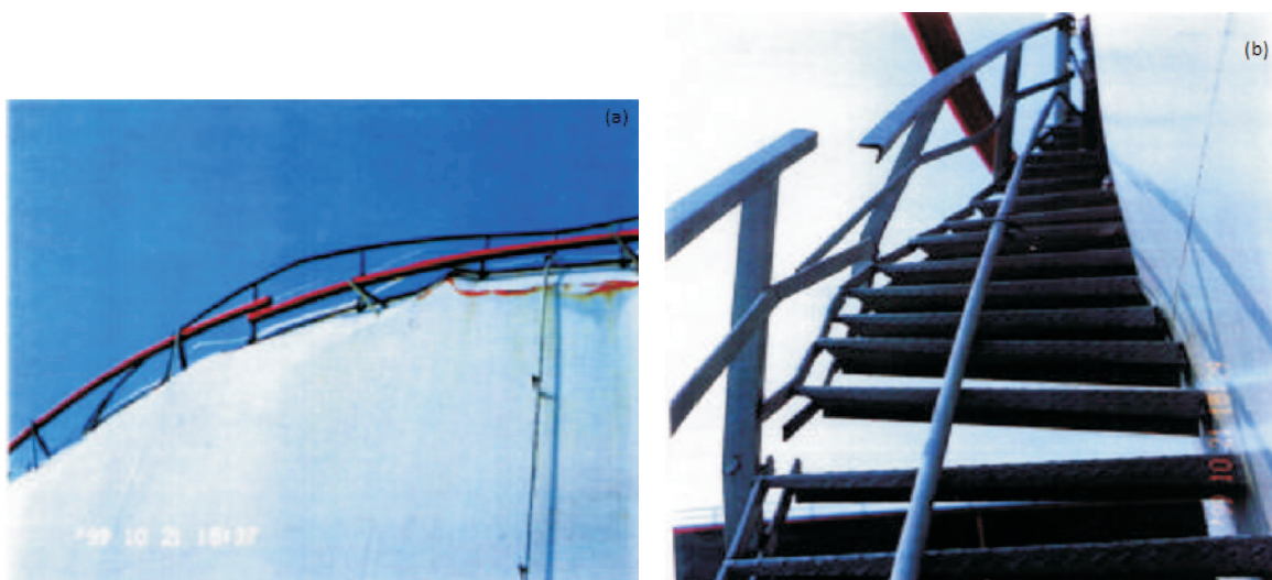
Figure 2.8 (a)Endommagement du système de lutte contre les incendies sur un réservoir - (b)Rupture des escaliers de maintenance d'un réservoir- lors du séisme de Chi Chi 1999 de magnitude 7.6 à Taiwan (Source : Chen et Chiang (2000))
