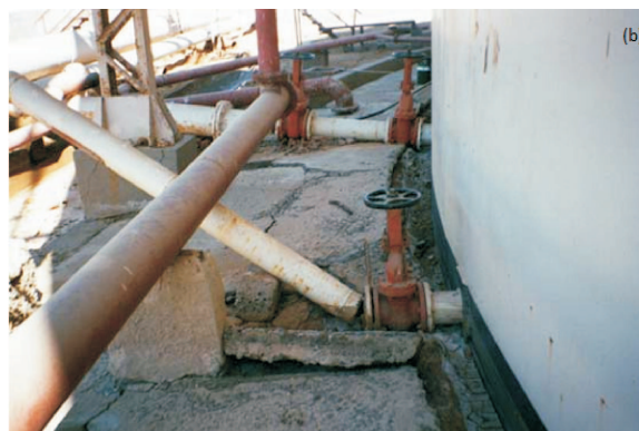
Figure 2.6 Glissement de la base d'un réservoir lors du séisme de Buhj 2001 en Inde (Source : Malhotra (2006))
