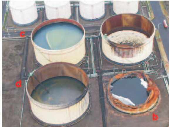
Figure 2.11 Naufrage de toit flottant dans deux réservoirs (C et D) de kérosène lors du séisme de Tokachi-Oki 2003 de magnitude 8.0 au Japon (Source : Hatayama (2007))
