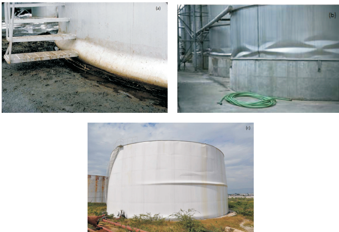
Figure 2.4 (a) Réservoir avec déformation de type "elephant-foot" lors du séisme d'Alaska 1964 de magnitude 9.2 (Source : Applied Technology Council (2011))-(b) Réservoir avec déformation de type "diamond-shaped" (Source : Malhotra (2006))-(c) Réservoir avec déformation de type "elephant-knee" lors du séisme de Port-au-Prince 2010 de magnitude 7 (Source : Applied Technology Council (2011))
