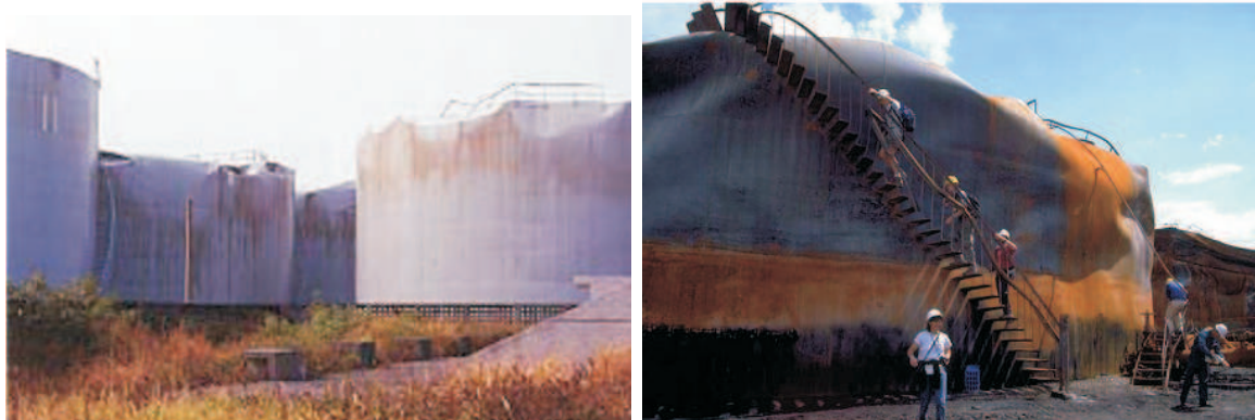
Figure 2.14 (a) Implosion d'un réservoir cylindrique à toit fixe (Source : Malhotra (2006)) (b) Destruction par le feu d'un réservoir de pétrole lors du séisme de Kocaeli 1999 en Turquie (Source : Sezen et al. (2000))
