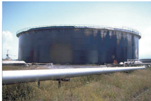
Figure 2.12 Débordement d'un réservoir due au ballotement lors du séisme de Kocaeli 1999 en Turquie (Source : Sezen et al. (2000))
