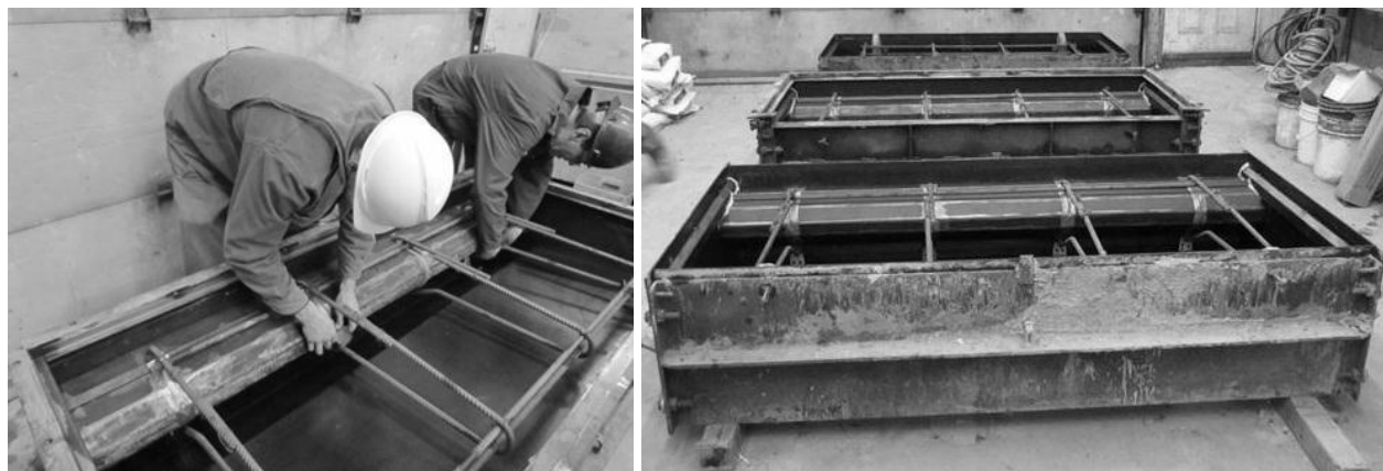
Figure 5-16: Precast Barrier Pour Preparation
