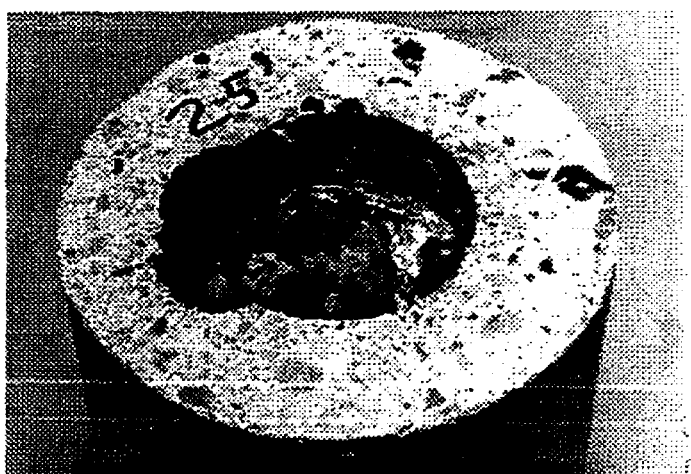
Figure 5.24 - Essai # 25, champignon en contact avec région corrodée.
