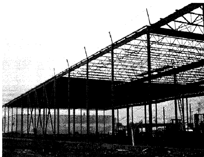
Figure 1 Structure typique en acier d'un seul étage
