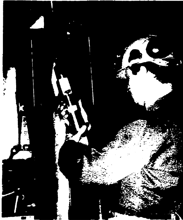
Figure C.7 : Mise en place du « DDGS » sur le câble de forage
