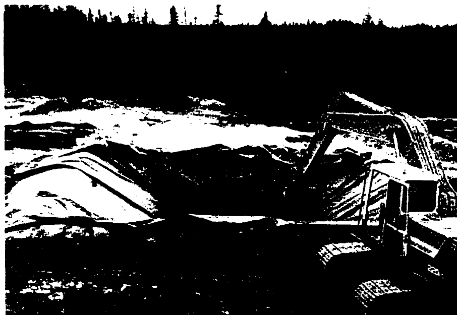
Figure 3.21 : Mise en place de la couche de résidus miniers sulfureux générateurs de DMA
