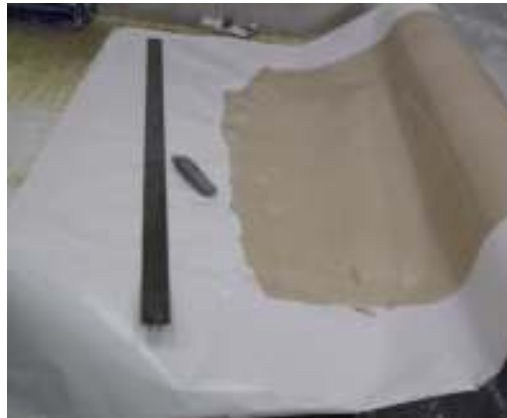
(b) Mode opératoire de la découpe du film de résine
