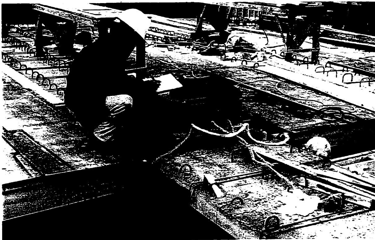
Figure 3.10: Câblage de la poutre P2
