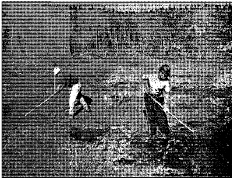
Figure 3.9: Nettoyage de la zone excavée au moyen de râdeaux, afin d'enlever les particules grossières qui peuvent être susceptibles de perforer la géomembrane.
