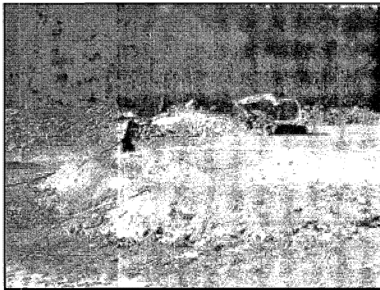
Figure 3.12 : Humidification du sable pour le compactage
