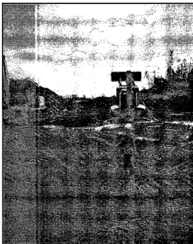
Figure 3.18: Pose de la surverse a) début de la mise en place de la couche de sable supérieur avant le raccordement de la surverse au tuyau servant d'exutoire b) mise en place de la surverse.
