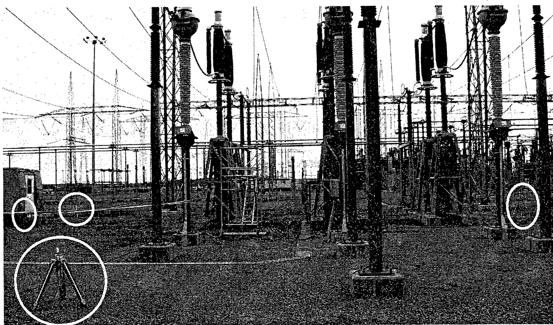
FIG. II.10 Disposition de quatre antennes (encerclées en jaune) en périphérie du disjoncteur. Les différences de temps d'arrivée (DTA) du signal rayonné entre les antennes permettent de déduire la position de la source de rayonnement (section 3.7).
