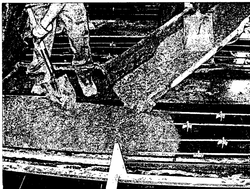
Figure 7-4 Mise en place du BFHP50 - 3 juin
