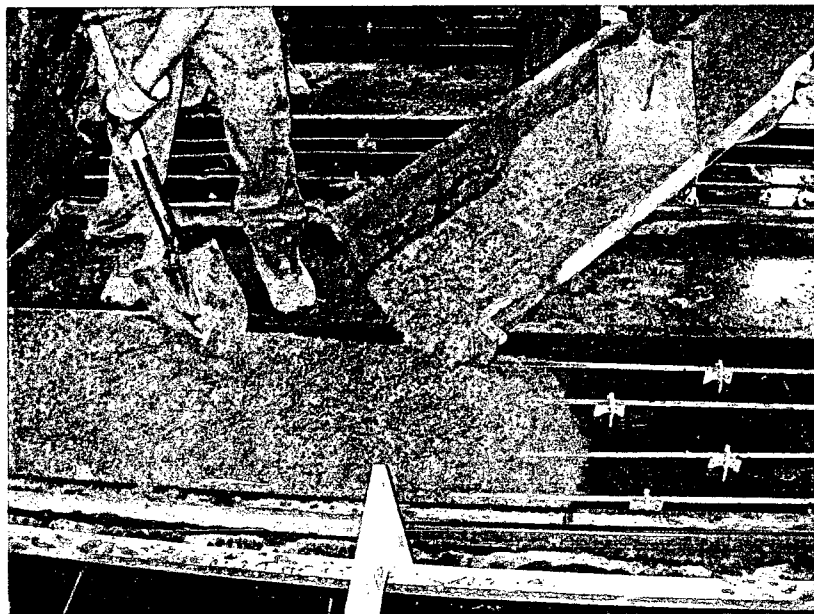
Figure 7-4 Mise en place du BFHP50 - 3 juin
