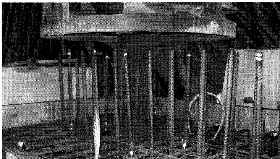
Figure 4.7 – Coulée de la semelle
