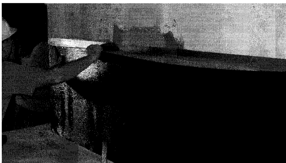
b) Installation de la première couche de tissu de composite
