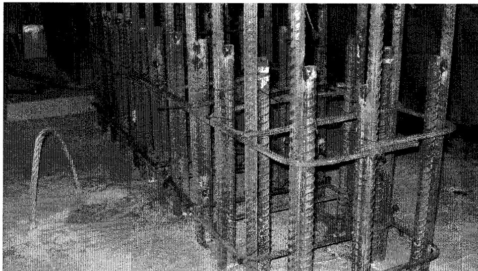
Figure 4.13 – Installation de la cage d'armature du pilier 3 sur la semelle
