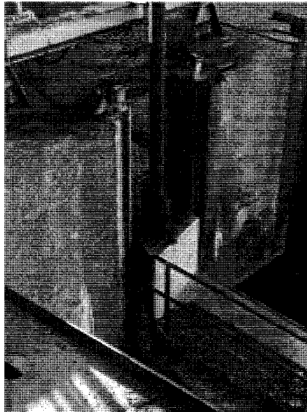
Fig. 2.9 Évacuateur de crues avec vannes muni d'un système de levage à treuils et à vis : a) évacuateur de crues étudié; b) structure d'acier et équipements de levage de l'évacuateur de crues étudié; c) vis de levage accrochée à une vanne en position levée pour un autre évacuateur de crues du même type
