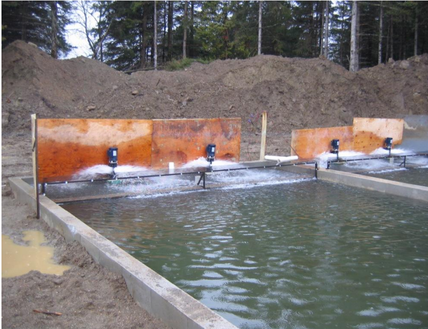
Figure A4-1: Entrée d'eau assurée par 2 "fresh-flows"
