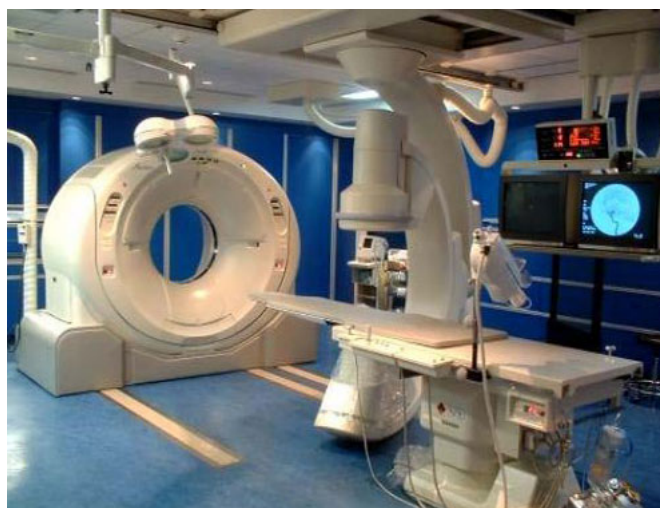
Figure 1.14. Plateforme d'angiographie interventionnelle du centre hospitalier universitaire de Sherbrooke (CHUS) combinant un CT scan et un C-arm (fluoroscope).
