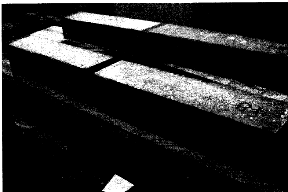
Figure 4.14: Surface traitée par des stries en diagonal et trous Ø12 mm
