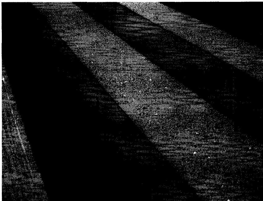
Figure 8.12: Préparation de surface avant de collage du composite - jet de sable
