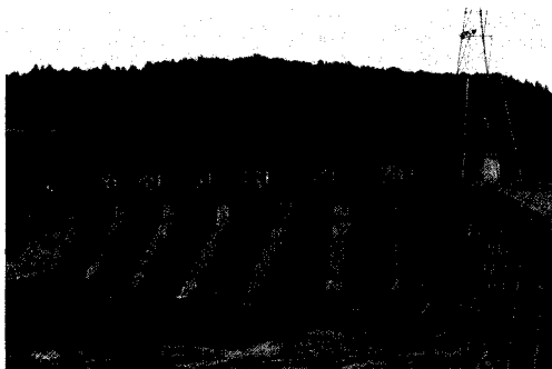
Fig. 2.1. Piliers d'évacuateurs de crues
