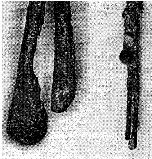
Figure 2.17 : Conducteurs de cuivre oxydés montrant un endommagement thermique (Babrauskas 2004)
