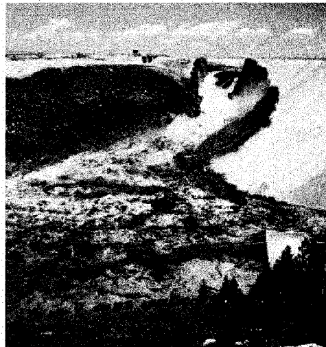
3 - La brèche s'élargit alors en rive gauche car la rive droite est bloquée par la présence du roc
