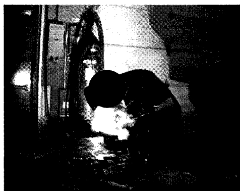
Figure 2.6 : Soudure au poste D
