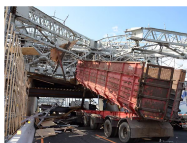
(f) Plastification puis rupture, Seto 2016 [26]
