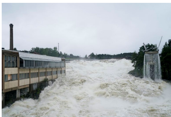
(d) Rupture d'un barrage à Braskereidfoss, Norvège, 2023
