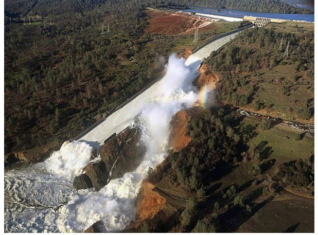
(b) Crise du barrage d'Oroville (2017)
