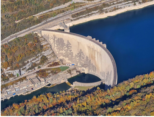
(a) Barrage de Vouglans (France)
