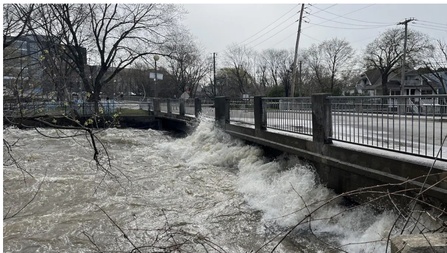
FIGURE 1.3 Pont de Saint Jérôme dans les Laurentides en 2013, (Radio Canada / Jacaudrey Charbonneau)
