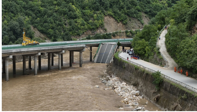
FIGURE 2.4 Effondrement d'un pont dû aux inondations après une tempête dans la province du Shaanxi, Chine, 2024 [10]
