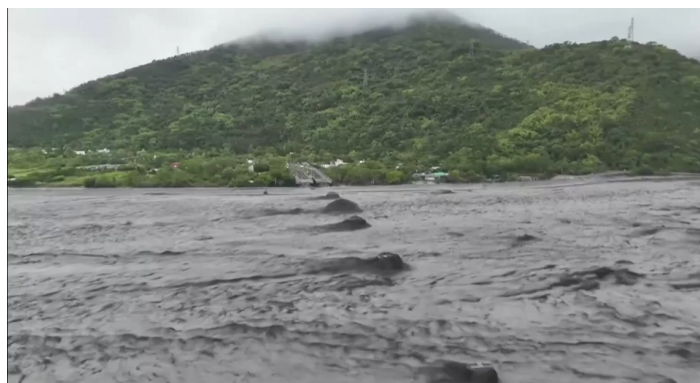
FIGURE 2.1 Pont emporté après les inondations dues au typhon Ragasa près de Guangfu, Taiwan, 2025 [7]
