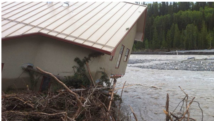
FIGURE 1.1 Une maison détruite à Benchlands dans le sud de l'Alberta, à la suite des inondations de juin 2013. [4]
