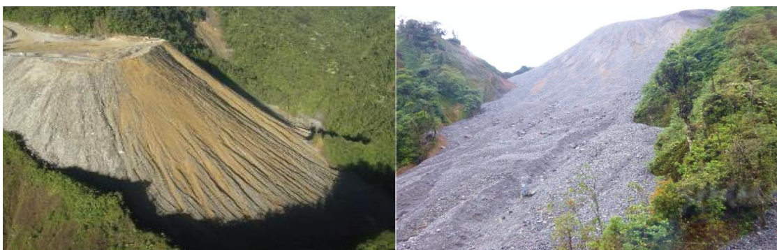
Figure 2.5: Dépôt de remblai en enrochement de Vancouver (mine de cuivre-or Ok Tedi) (Bar et al., 2020)
