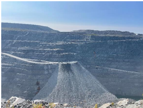
Figure 2.6 : La berme centrale (CB) de la mine à ciel ouvert Canadian Malartic (García-Torres et al., 2024).
