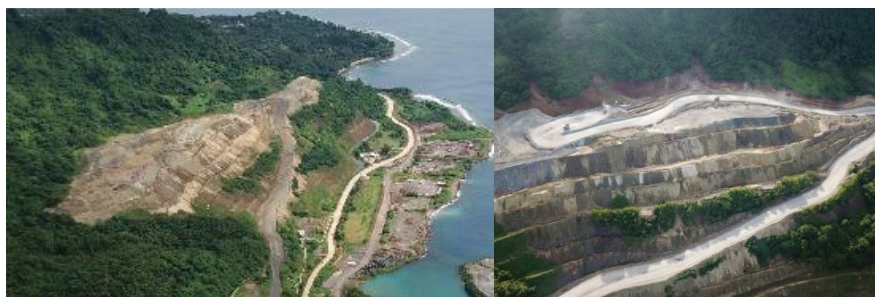
Figure 2.7 : Stockpile de Kapit North (Lihir) construction ascendante (Bottom-Up) : (a) vue aérienne ; (b) préparation des niveaux supérieurs pour la levée suivante (Bar et al., 2020).
