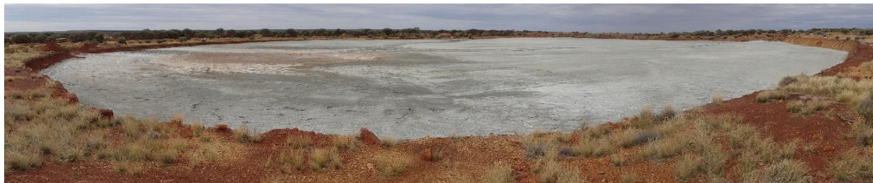
Figure 1.1: Stockage des résidus miniers dans la fosse Perch (mine Plutonic, Pilbara, Australie-Occidentale) (McCullough et al., 2024)
