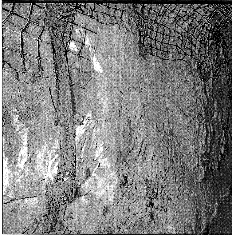
Figure 6.42. Image finale pour l'essai situé à l'arrière côté J du niveau 14.
