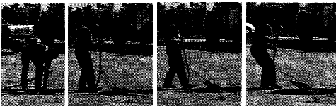
Figure 1.4 : Ouverture d'un tampon sans pattes à l'aide du protol
