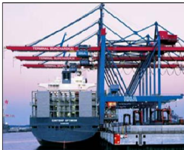
2- Portique de quai
