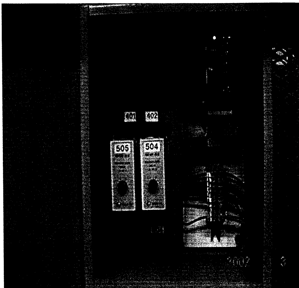
Figure A3.45 Relais haute impédance (HI) (1982 et 85)
