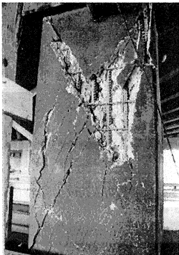
Figure 2.3 – Rupture fragile en cisaillement (Séisme de Whitter selon Priestley 1992)
