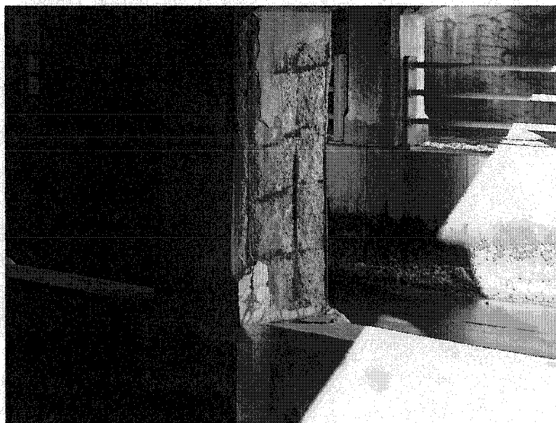
Figure 2.5 – Fissuration prématurée des piles de ponts en béton
