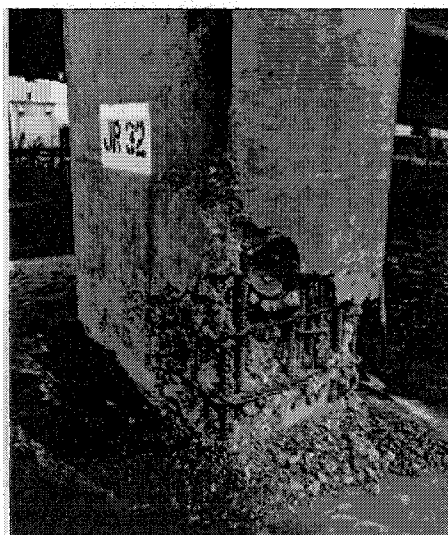
Figure 2.4 – Rupture du chevauchement d'armature (Séisme de San Fernando selon Priestley 1992)
