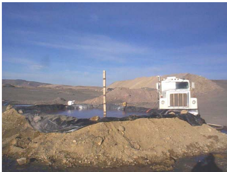
Figure 3.9 Bassin TP-1 rempli (avec la fluoricine dans l'eau).
