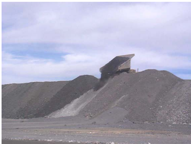
Figure 3.3 Camion de halage qui s'apprête à décharger sur une pente d'une hauteur de 50 pieds (15 mètres).
