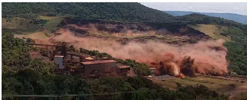
Figure 2.7 : Photo au moment de rupture de digue Feijao (Robertson et al., 2019)
