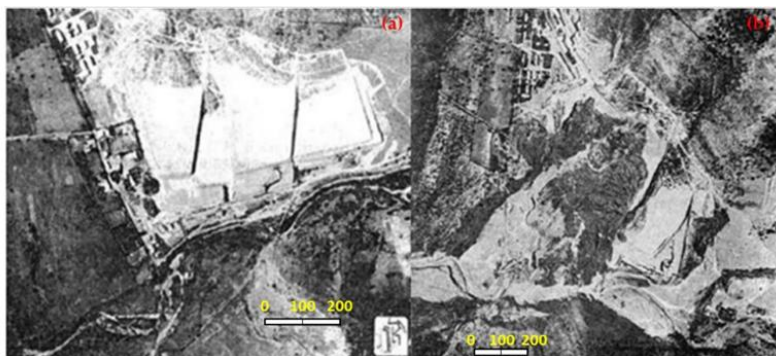
Figure 2.9 : La digue d'El Cobre avant (a) et après (b) la rupture (Cacciuttolo & Atencio, 2022)
