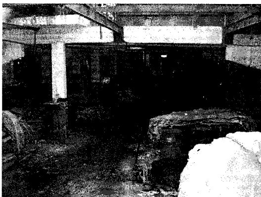
1. La tannerie, vue de l'intérieur
