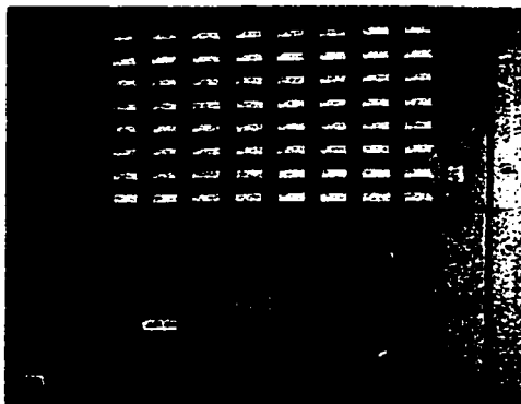
(a) Annonciateur Positron du poste ouest de Beauharnois
