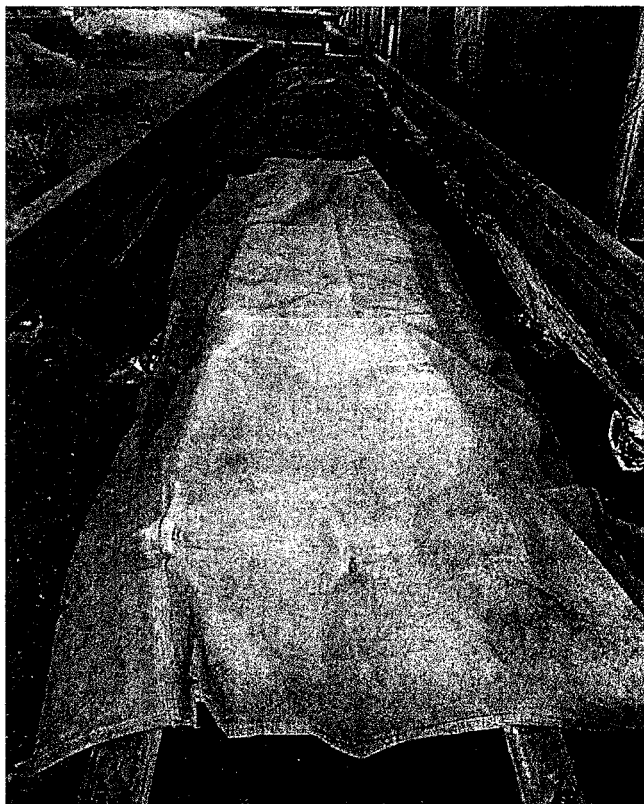
Figure 3.10 : Cure du béton
