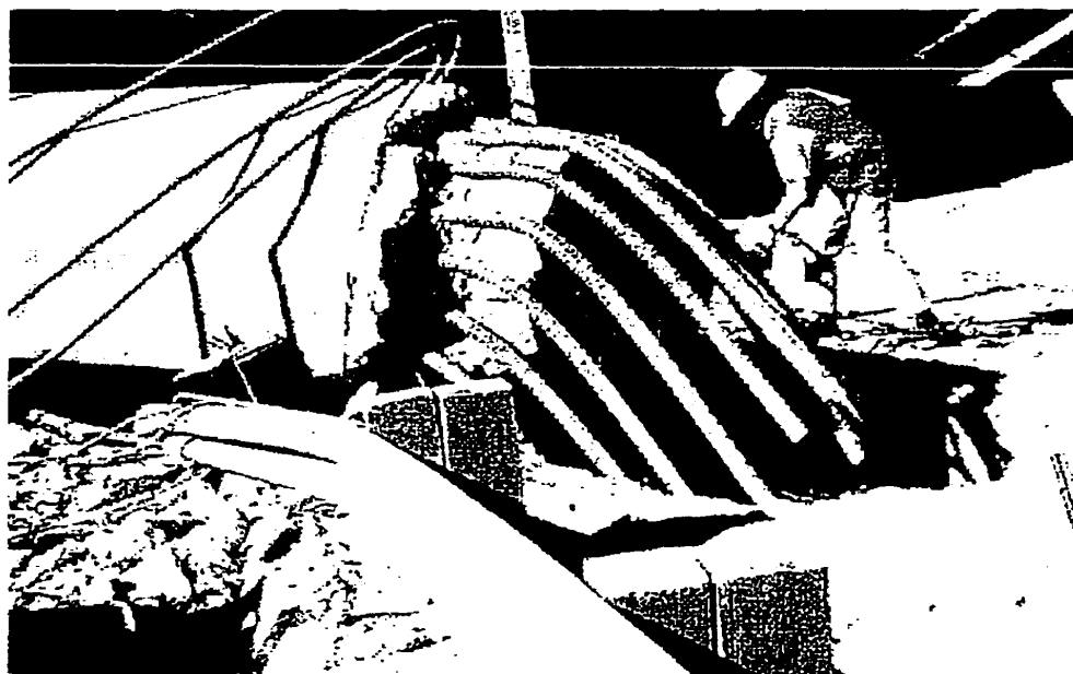
Figure 2.6 : Rupture de poteau par arrachement , 1971 San Fernando (adaptée de Priestley et al., 1996)
