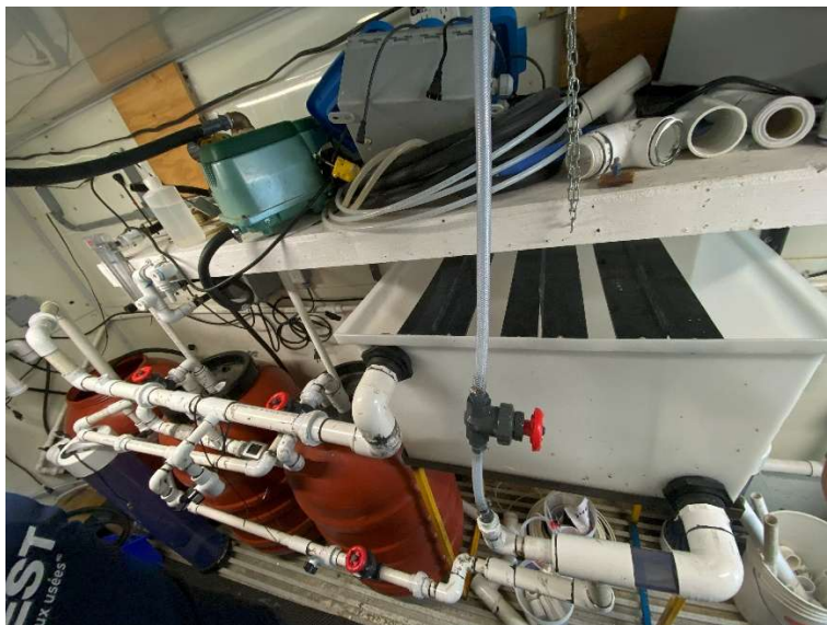
Figure C 2 Traitement tertiaire : Décanteur, filtres à scories e neutralisation
