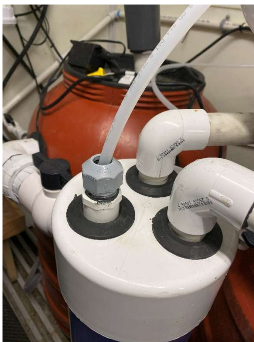
Figure C 5 Isolement des bouchons de recirculation dans la tête de la station de pompage
