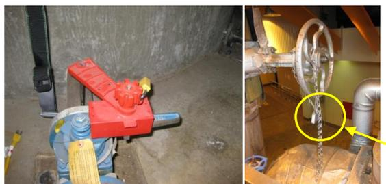
**Figure 1-2 Exemples d'application de cadenas sur des dispositifs d'isolement pour l'énergie hydraulique (ex., vanne)**
