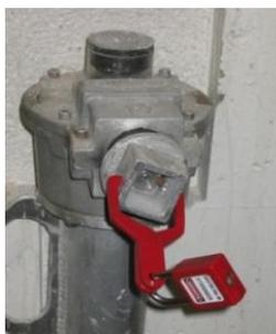
**Figure 6-4 Accessoire de cadenassage développé pour les vannes à actionneur carré**
