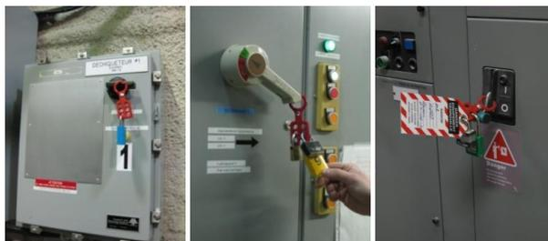
**Figure 1-1 Exemples d'application de cadenas sur des dispositifs d'isolement pour l'énergie électrique (ex., disjoncteur, sectionneur)**
