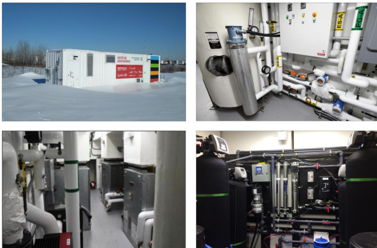
FIGURE 2.8 Laboratoire mobile de géothermie de l'École Polytechnique de Montréal situé installé dans la ville de Varennes, Québec, de gauche à droite et de haut vers le bas : une vue du conteneur maritime, de l'unité de chauffage pour les essais de réponse thermique, des pompes à chaleur et de l'unité de traitement de l'eau (tiré de Beaudry et al., 2019).
