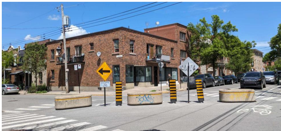
Figure 3-4 : Déviateur à l'intersection Villeray / Sainte-Dominique
