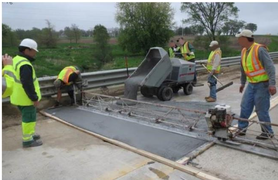
Figure 2.21 Mise en place de la chape en BFUP à l'aide d'un mini camion-benne et son compactage avec une règle truelle vibrante (Haber et al., 2018)
