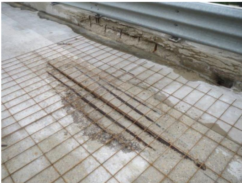
Figure 1.2 Zone détériorée sur la voie en direction ouest du Laporte Road à Iowa, États-Unis (FHWA-HRT-17-096, 2017)
