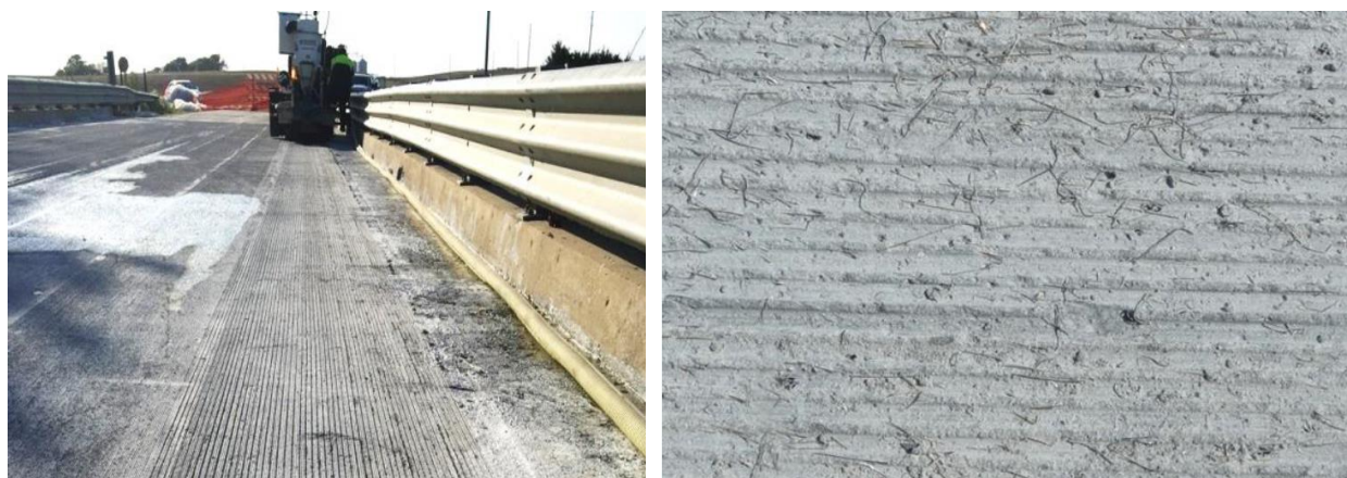
Figure 2.26 Finition de surface du BFUP à l'aide de la scarification (Wibowo & Sritharan, 2018)
