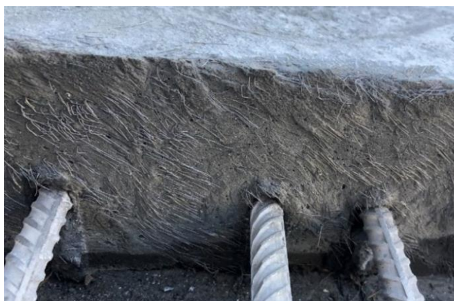
Figure 2.22 Finition avec fibres exposées sur un joint de construction de BFUP (FHWA-HRT-22-065, 2022)
