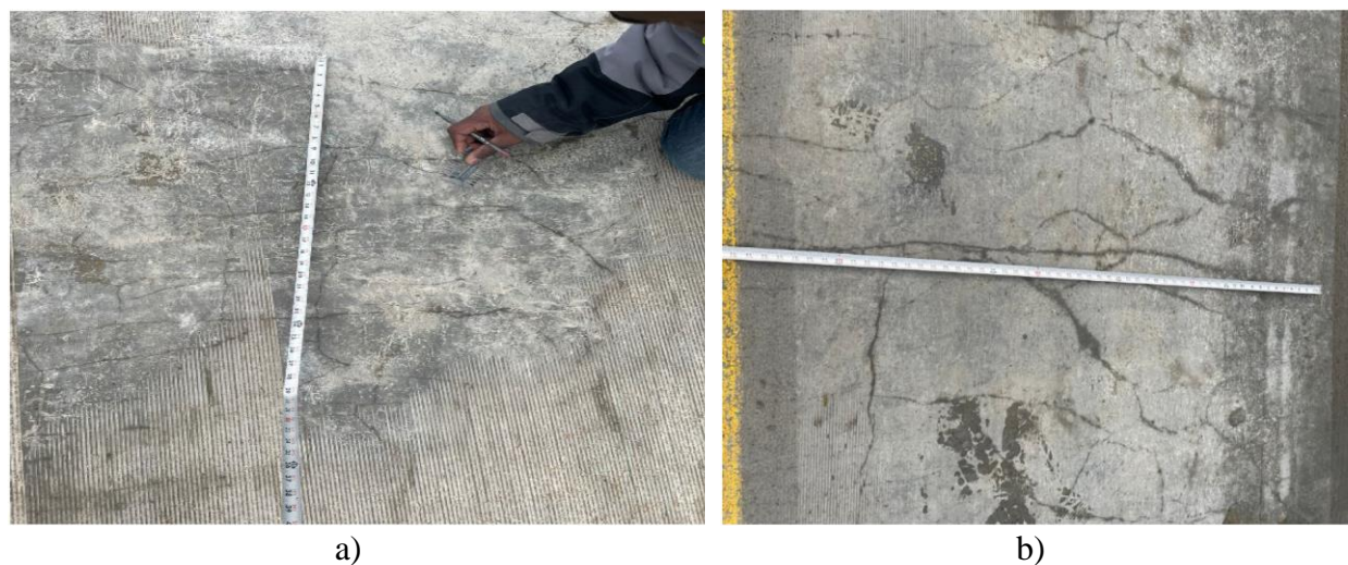
Figure 2.31 Fissures apparentes en surface des chapes mince en BFUP sur le pont, a) Route Z, b) Route M (Khayat et al., 2023)
