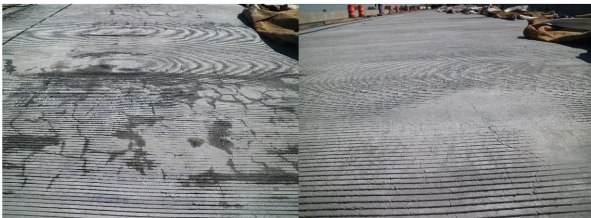
Figure 2.25 Apparition de fissures sur la 1 ère coulée d'une chape mince de BFUP (Alvarez et al., 2024)
