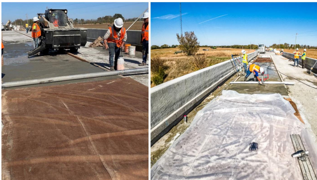
Figure 2.24 Cure du BFUP, a) Application d'un retardateur d'évaporation au BFUP fini, b) Toile de jute humide et feuille de plastique (suite) (Khayat, 2023)
