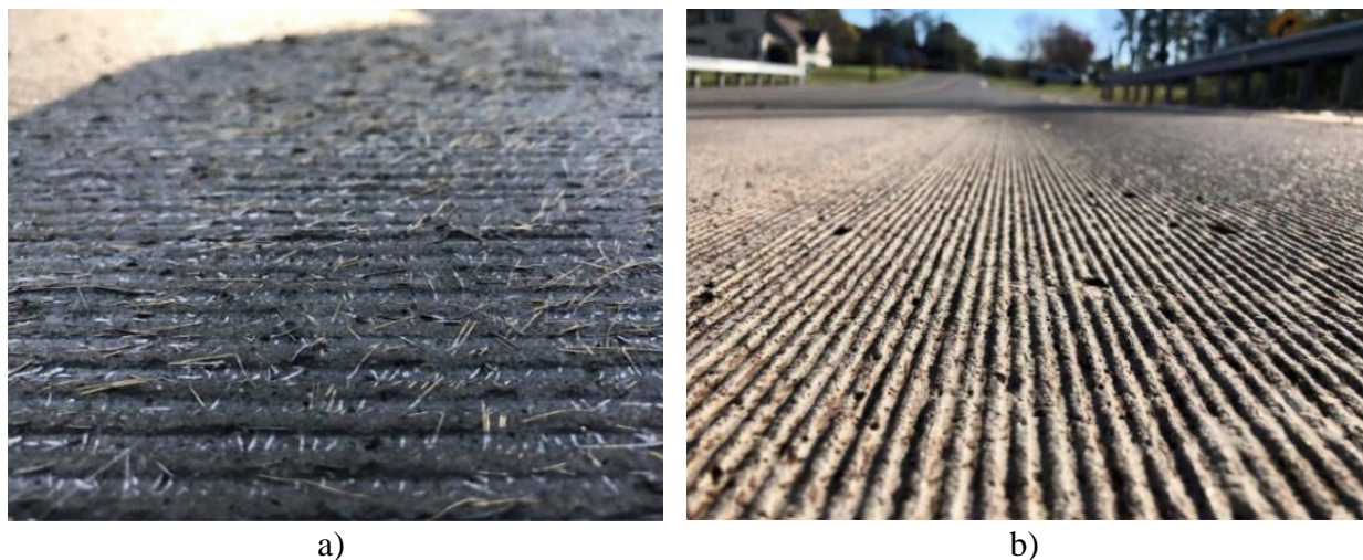
Figure 2.35 Finition de surface de roulement du BFUP a) peu après la mise en place b) après 2 ans en service (FHWA-HRT-22-065, 2022)
