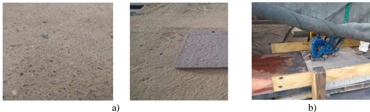
Figure 2.16 a) Finition de surface par grenaillage b) Équipement utilisé (Helsel et al., 2023)
