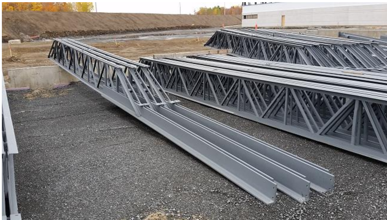
Figure 2-2 Exemple de poutrelle CANAM avec extension de corde supérieure – photo prise sur un projet à Varennes en octobre 2014
