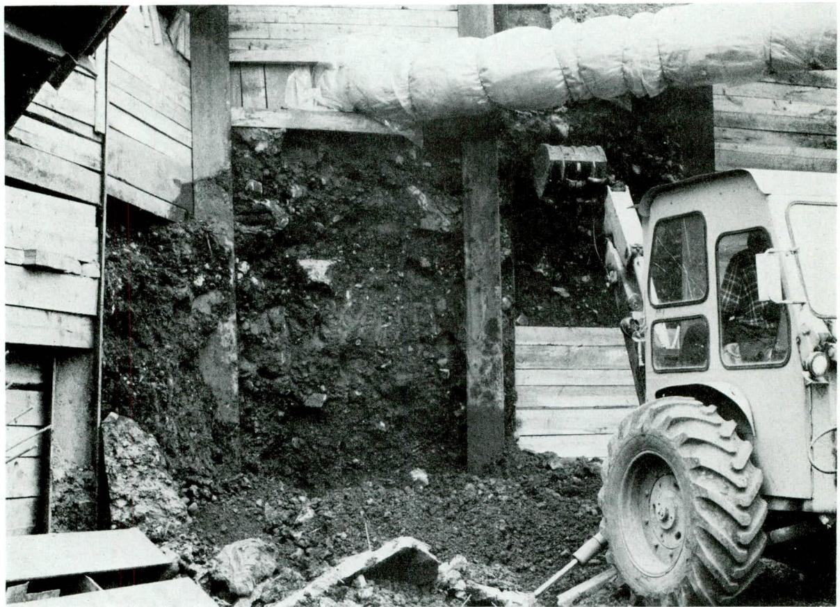
Fig. 26 - Till gris très compact et comportant 10 à 20 % de blocs plus grands que 30 cm.
