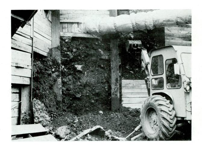
Fig. 26 - Till gris très compact et comportant 10 à 20 % de blocs plus grands que  $30\ \text{cm}.$
